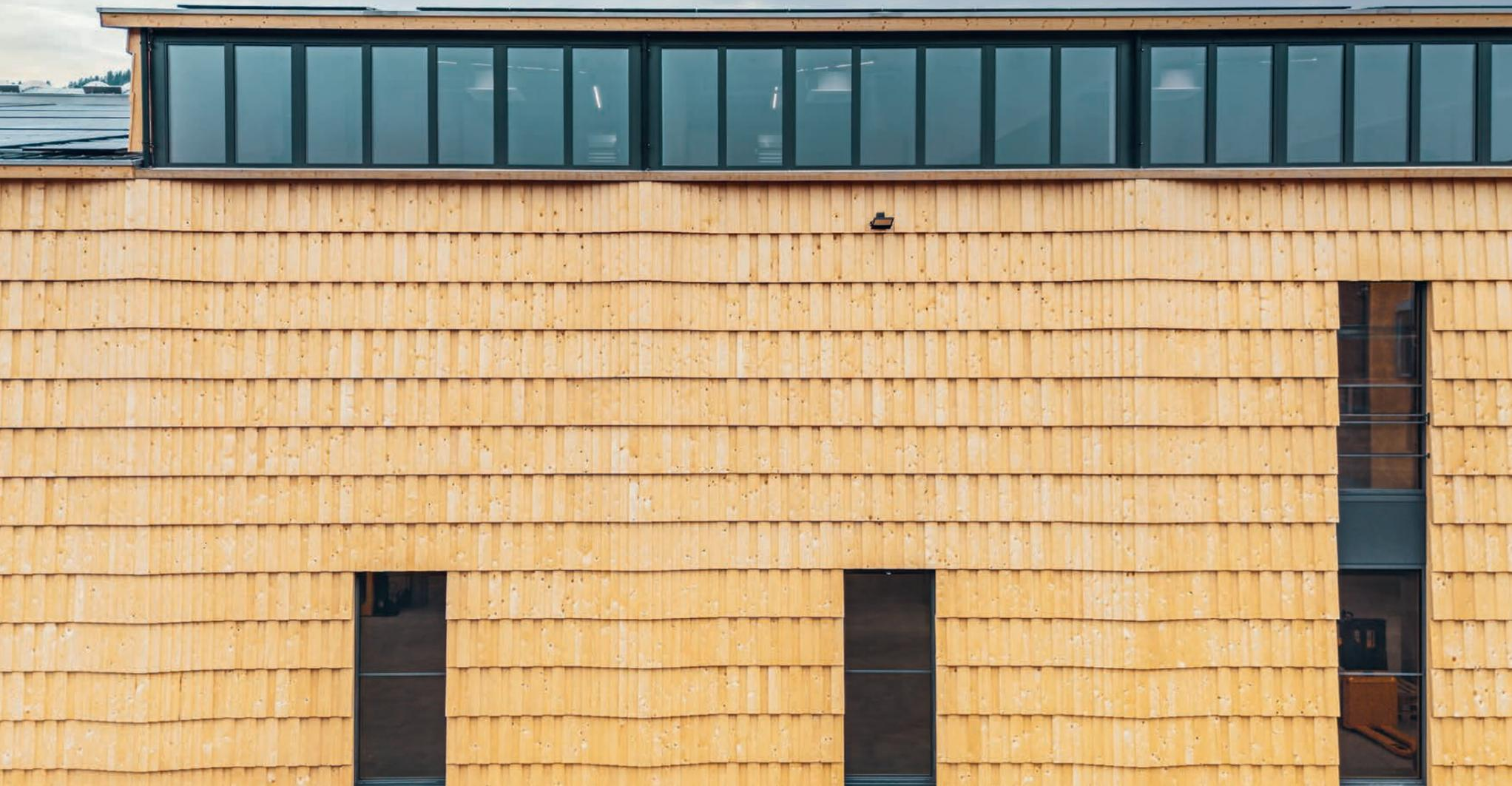
Die Nordfassade des Hochregallagers: Grossformatige Fichtenschindeln verkleiden die Holzstruktur. Darin lagern die Flaschen mit einem alkoholischen Bittergetränk.
